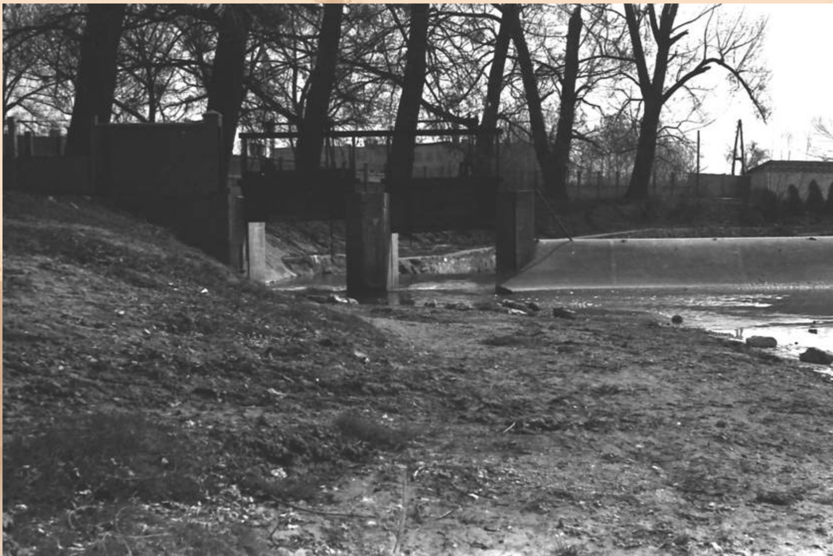
Duzzasztómű a Perint-patak régi strandjánál, 1966. 03. 23.
